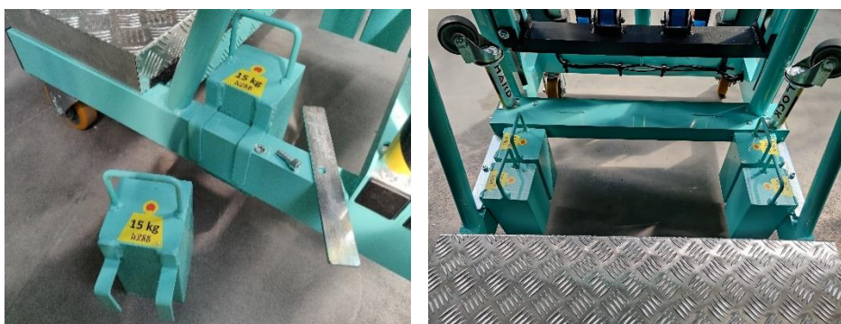
Zdjęcie 4. Montaż balastów
