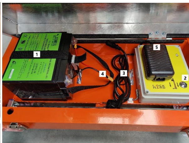
Zdjęcie 2. Skrzynka elektryczna
